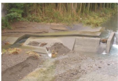
台風 15 号後も魚道に残る堆積土砂。来春、整備予定です。(川口地先)
