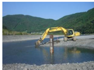
↑ 神座水位測定標の維持工事
